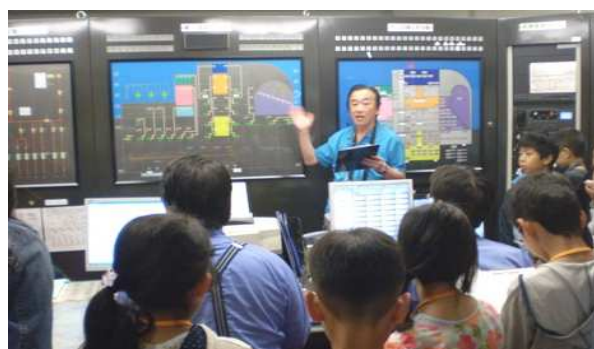
中央監視室の中にも入れていただきました。全館の安全を一括管理しています。
