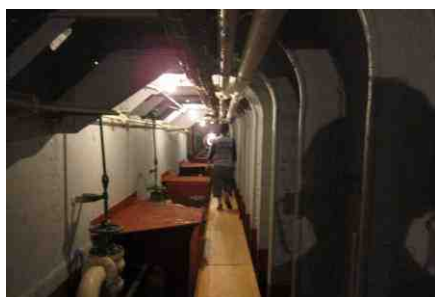
スクリーの軸があったシャフトトンネル
